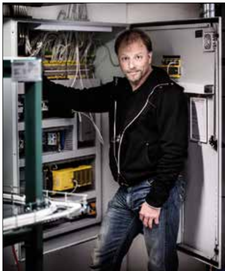
Björn Hultberg, Niwentec, vid den varvtalsstyrda kylanläggningen som driver höghöjdsrummet under olika förutsättningar.
